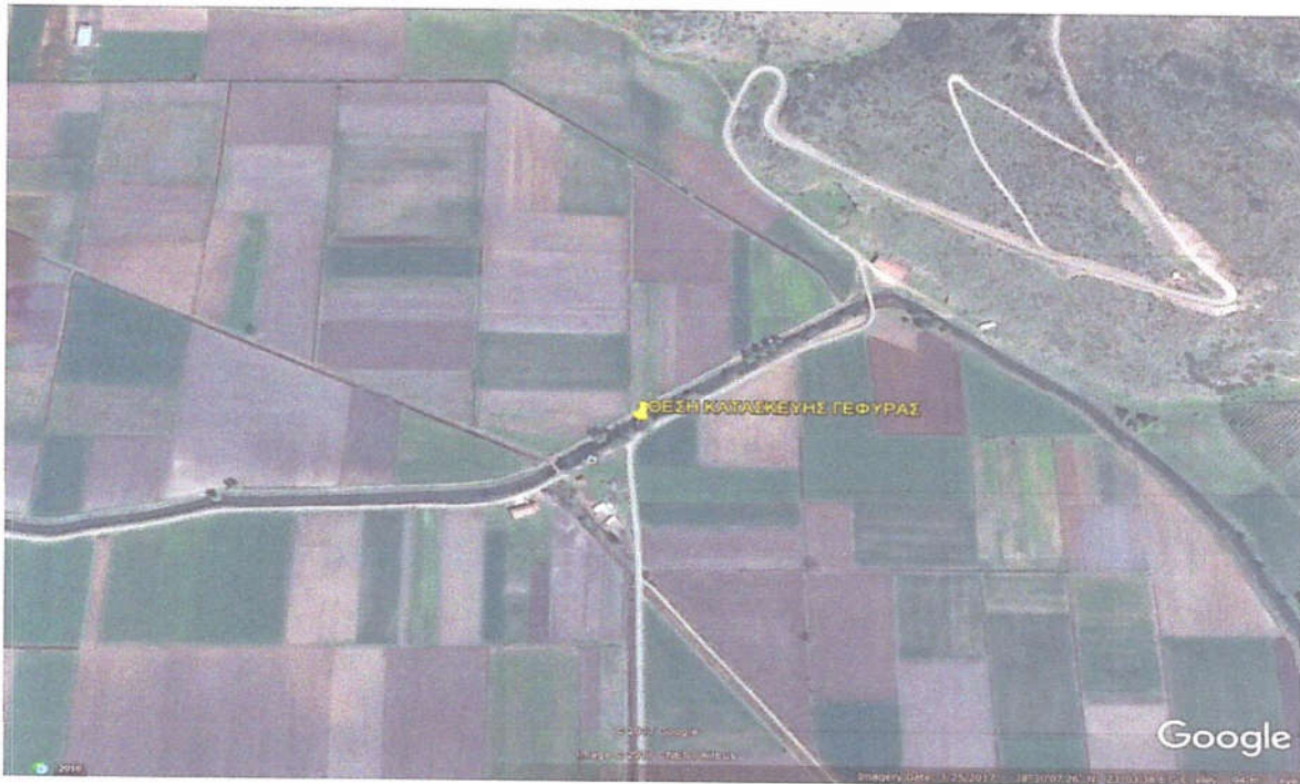
Εικ.2: Θέση κατασκευής της νέας Γέφυρας του έργου: «ΚΑΤΑΣΚΕΥΗ ΝΕΑΣ ΧΑΡΑΞΗΣ ΟΔΟΥ ΚΑΙ ΓΕΦΥΡΑΣ ΣΤΗ ΘΕΣΗ ΔΙΠΟΤΙ ΣΤΗ ΤΚ ΠΑΥΛΟΥ ΤΟΥ ΔΗΜΟΥ ΟΡΧΟΜΕΝΟΥ»
